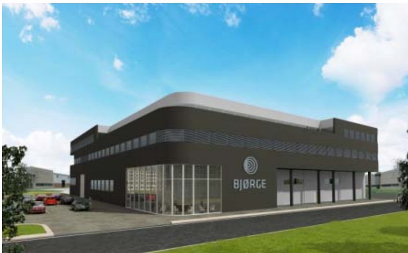
Nytt verksted og kontorbygg på Forus
